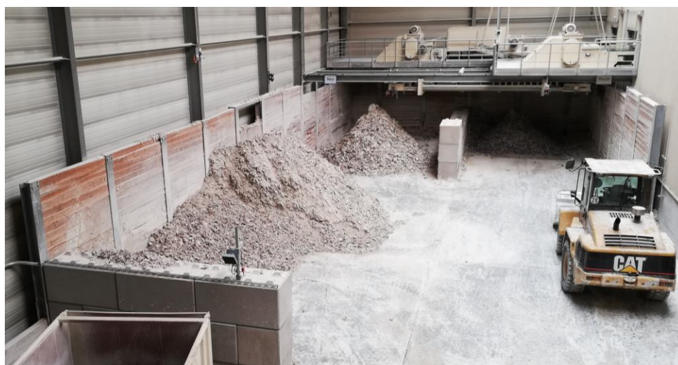
Abbildung 1: Nassausschuss Anlage an der die Container beladen werden
